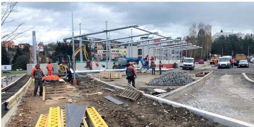
Koncem října se na staveništi už rýsovaly budoucí zastřešené nástupní ostrůvky.
