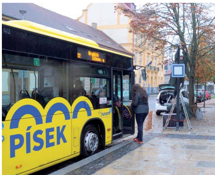
Instalace nových panelů na píseckých zastávkách.
