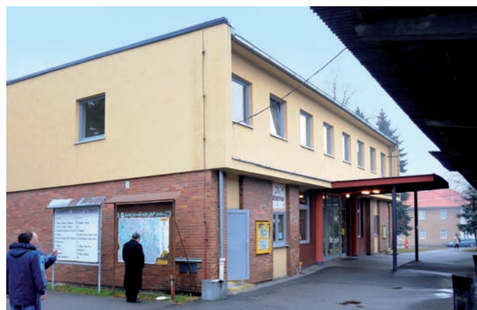
Zateplená a opravená nádražní budova v Prachaticích.
