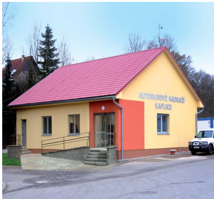
Nová provozní budova prosvítla autobusové nádraží v Kaplici.
