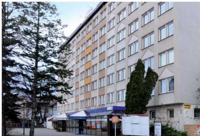
Vedení společnosti bude od ledna sídlit v tomto objektu v areálu bývalého PVT
