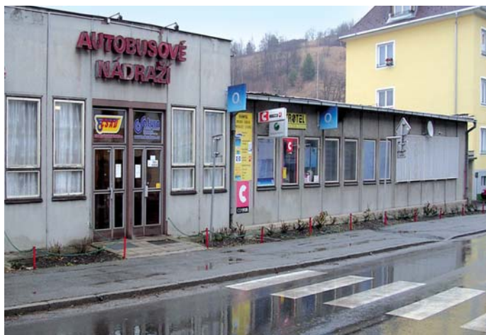
Autobusové nádraží ve Vimperku před modernizací
