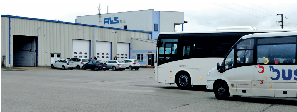
Depo vzniklo v prostorách pronajatých od NDC Real Estate. Vlevo vjezd do automatické myčky.
