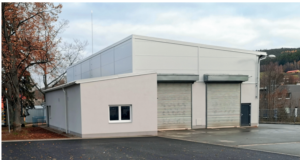
V přístavku je kancelář, pneuservis, sklad náhradních dílů a olejů.
