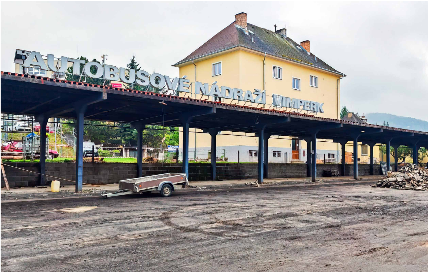
Rekonstrukce autobusového nádraží ve Vimperku.
