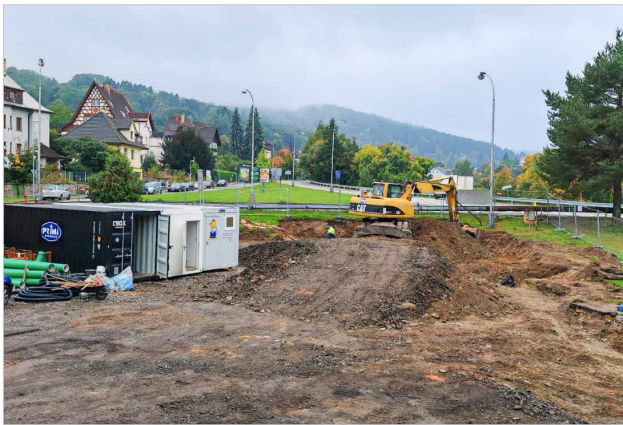
Rekonstrukce autobusového nádraží ve Vimperku.
